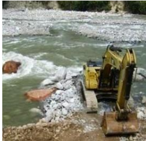
Descolmatación de río Tulimayo
