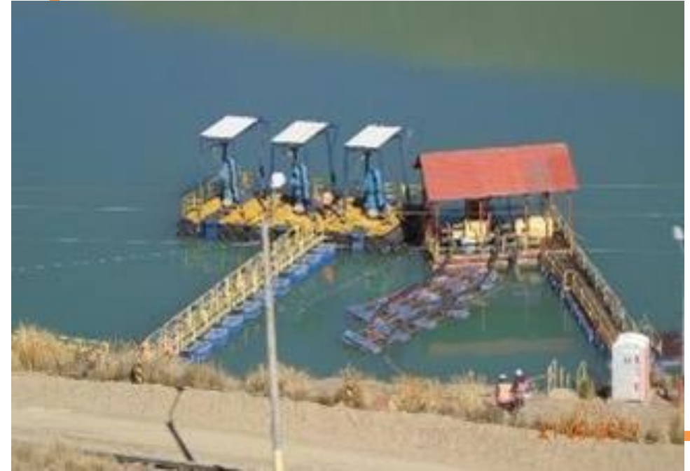
Instalación de Sistema de Bombeo Presa de Relaves – San Rafael
