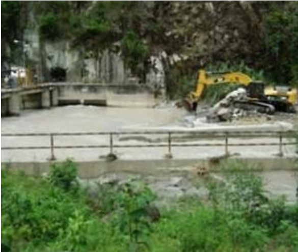
Limpieza de material sedimentado – Bocatoma
